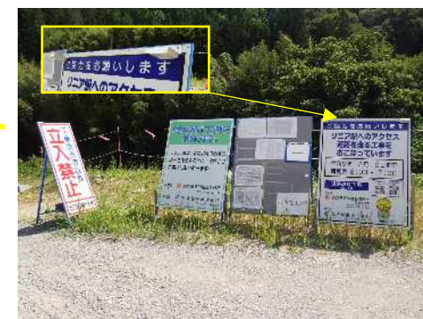
伝わる工事標示板(LED 照明付き)
