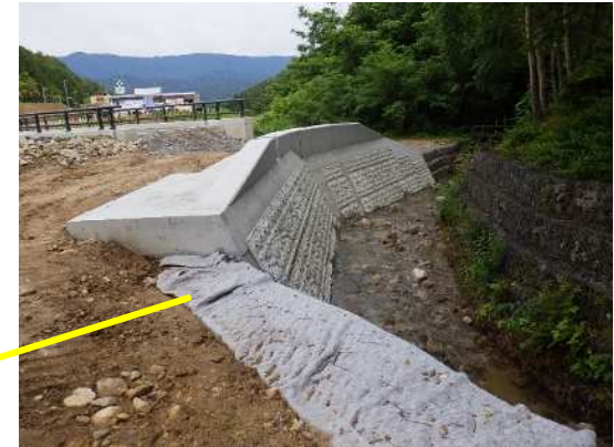
栃ヶ洞川 大型ブロック積
