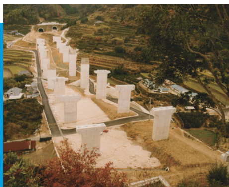
▲飛鳥建設時代：山陽自動車道門前橋下部工工事（昭和57年）
